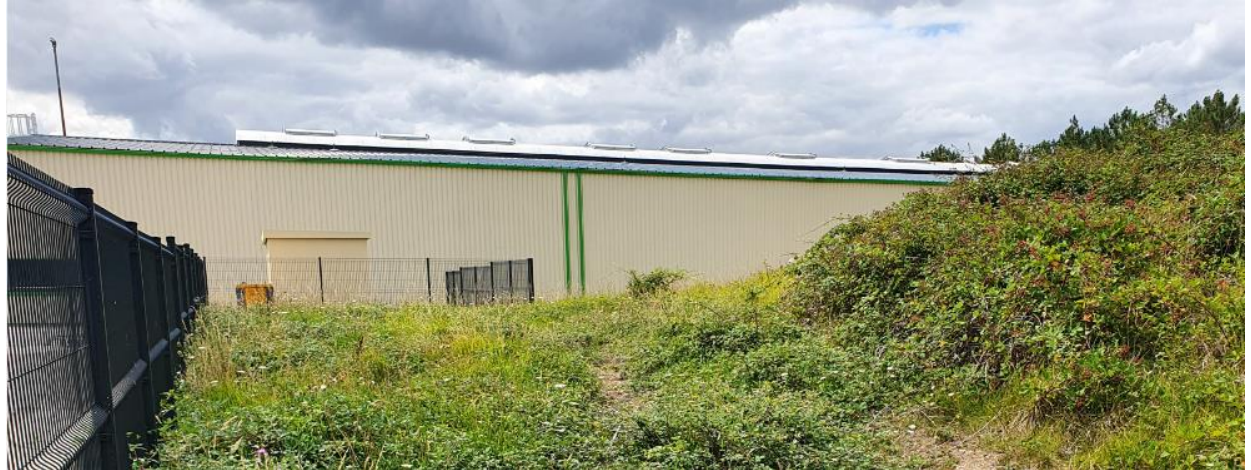
PHOTO 1 : FAÇADE EST DU BATIMENT 2
