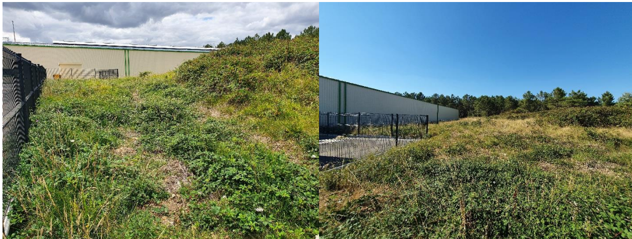
PHOTO 6 : VUES DU SUD DE LA ZONE DE TRAVAUX DE TERRASSEMENT
