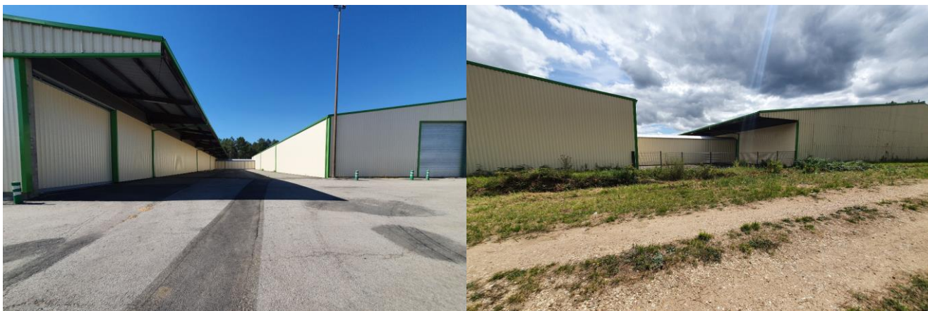
PHOTO 4 : TUNNEL RELIANT LES BATIMENTS 1 ET 2
