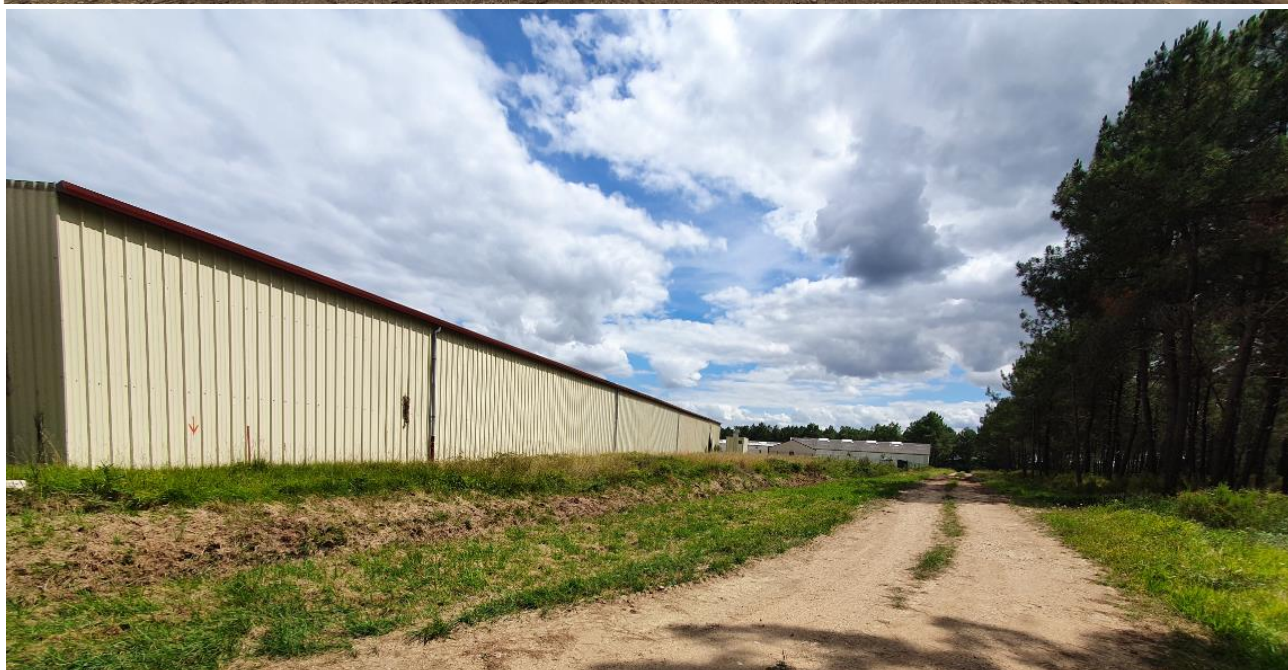
PHOTO 3 : FAÇADE DU BATIMENT 1 DU COTE DE LA ZONE NATURA 2000 "LANDES DU PINAIL" (NORD ET OUEST)
