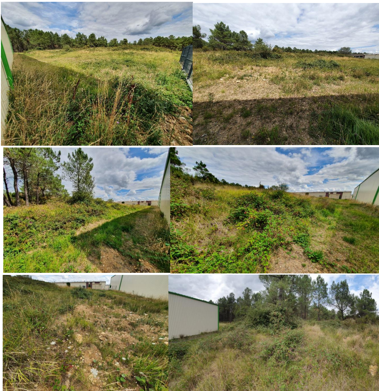
PHOTO 7 : VUES DE LA ZONE DE TRAVAUX DE TERRASSEMENT - EST BATIMENT 2
